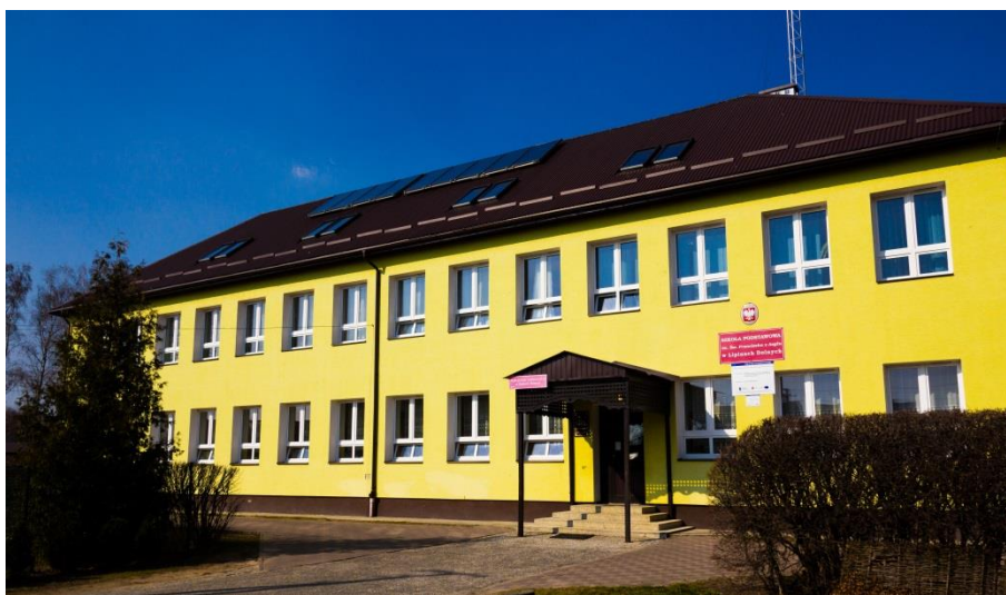
Kolektory słoneczne w Potoku Górnym
