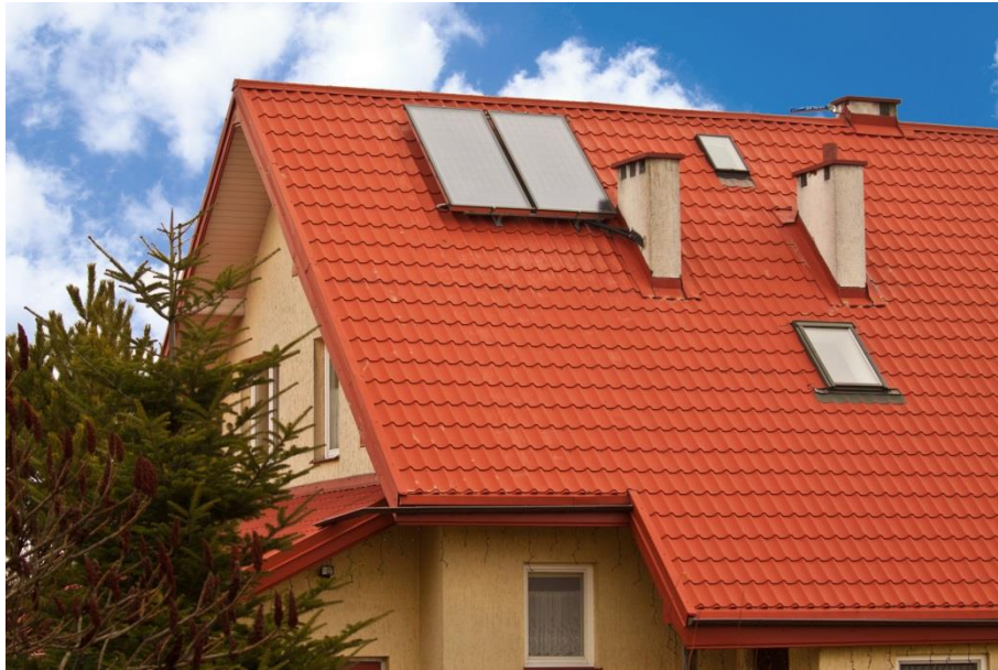
Kolektory słoneczne w miejscowości Ruda Huta
