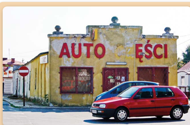
Czas zrobił swoje. Budynek byłej karczmy, a w zasadzie to co z niego zostało, przed odbudową
