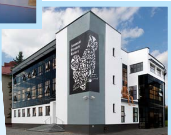
Modernizacja i rozbudowa Janowskiego Ośrodka Kultury w Janowie Lubelskim
